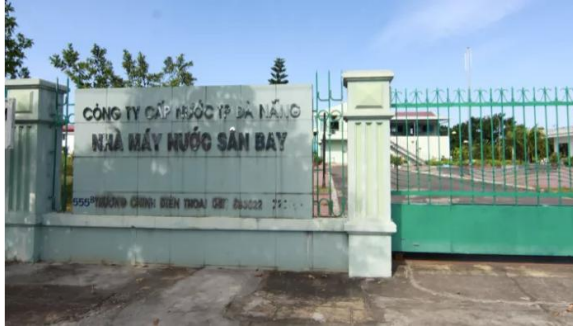
Hình 30. Nhà máy nước Sân Bay
