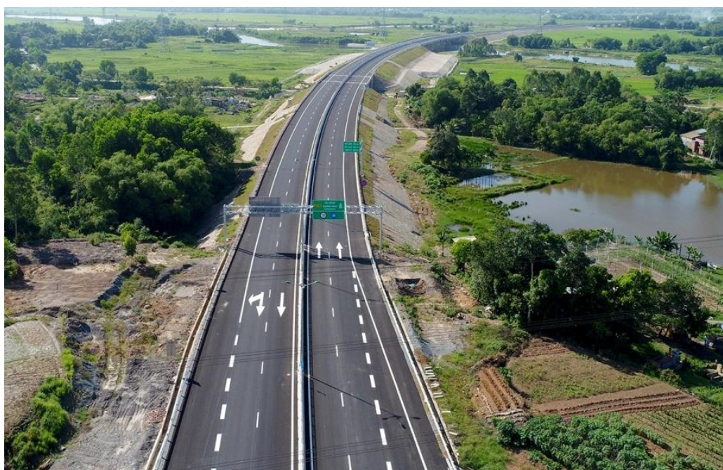
Hình 19. Cao tốc Bắc – Nam phía Đông đoạn Đà Nẵng – Quảng Ngãi
