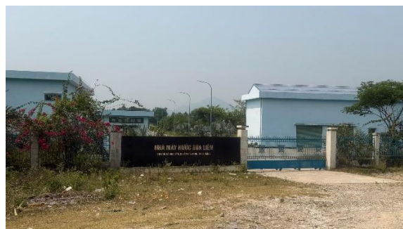
Hình 29. Nhà máy nước Hòa Liên
