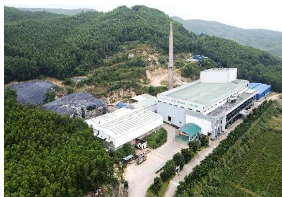
Hình 39. Nhà máy xử lý CTR sinh hoạt Bắc Quảng Nam
